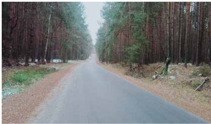
■ Przebudowa drogi gminnej Bobrowniki – Stawki.
