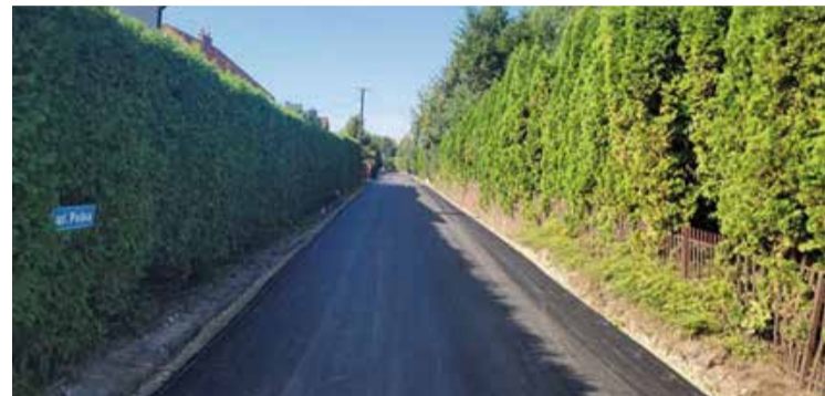
■ Budowa drogi gminnej w m. Brzóza ul. Polna.
