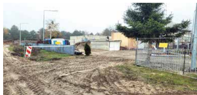
■ Przebudowa i rozbudowa oczyszczalni ścieków w Głowaczowie.
