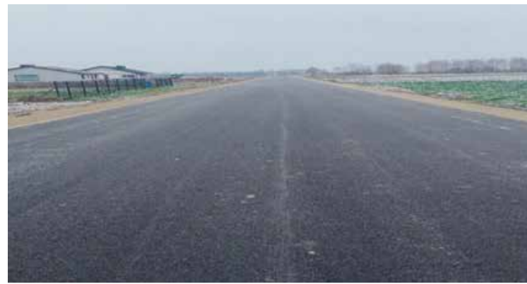
■ Budowa drogi gminnej w m. Brzóza ul. Stara Brzóza- etap I.
