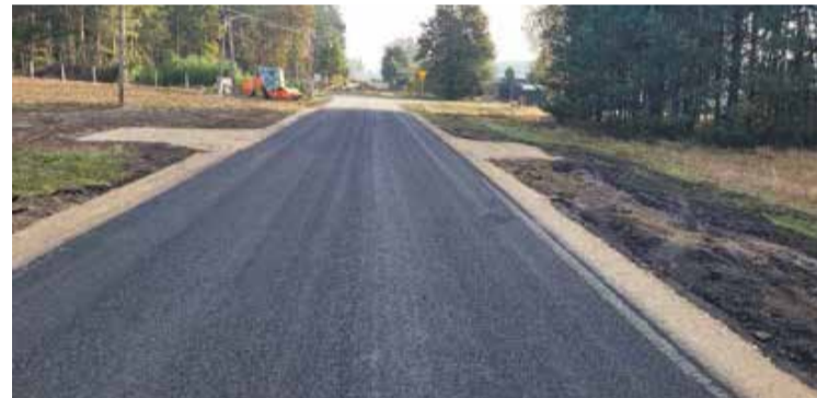
■ Przebudowa drogi gminnej odcinek Mała Wieś - Klementynów.
