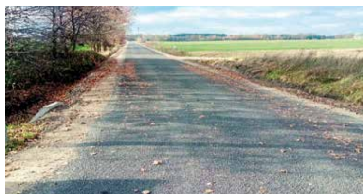
■ Przebudowa drogi gminnej w miejscowości Miejska Dąbrowa (Przecinka).
