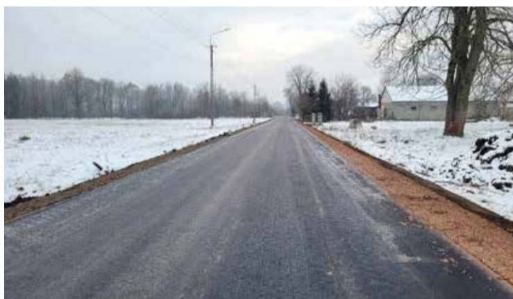
■ Przebudowa drogi gminnej w miejscowości Studnie.
