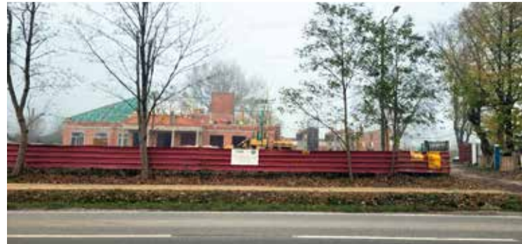
■ Budowa strażnicy OSP wraz ze świetlicą wiejską i infrastrukturą towarzyszącą.
