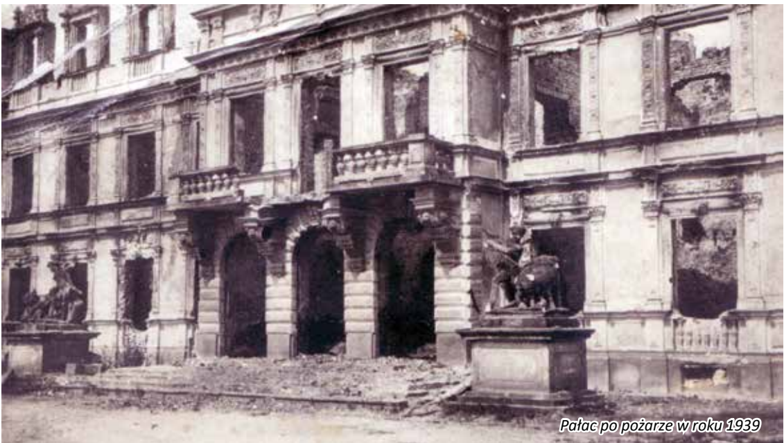
Pałac po odbudowie na przełomie lat 50. i 60
